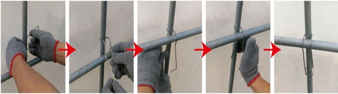
Hình 1. Cách kết nối thanh dọc - ngang sử dụng móc ngoàm
