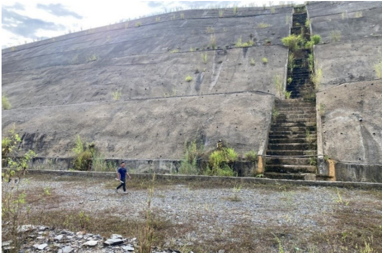
Hình 14. Công trình bảo vệ mái dốc phía sau UBND thị xã Mường Lay
